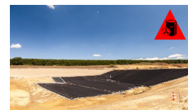
Relleno de seguridad
